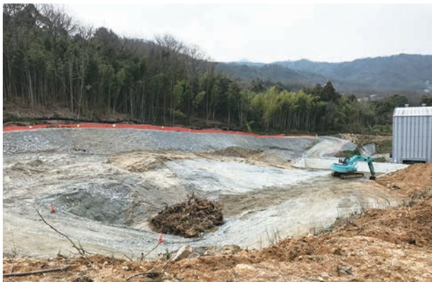
工事中の多目的グラウンド(予定)
