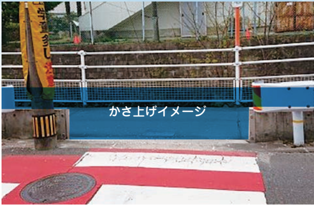
かさ上げされる止水壁
