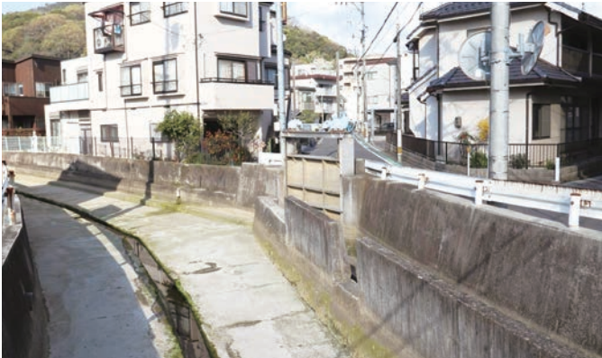
新町付近での浸水対策です
