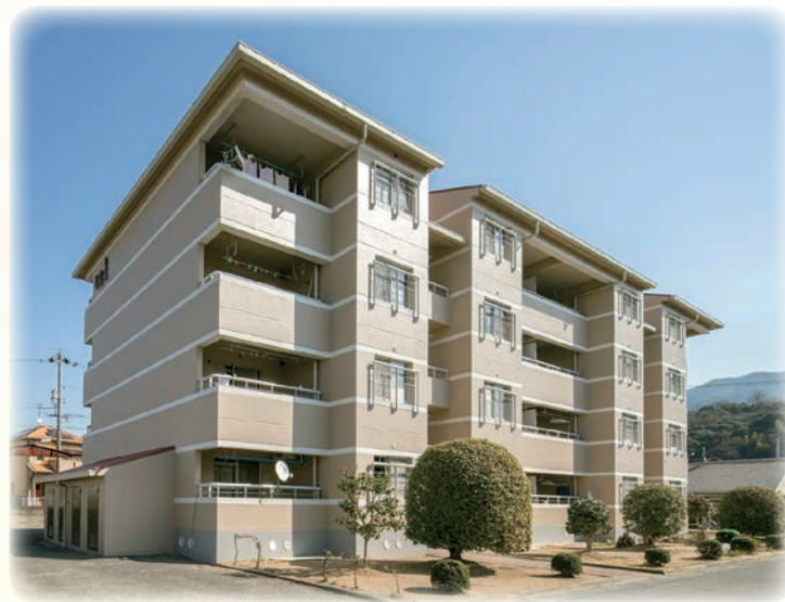
これから内装を改修します
