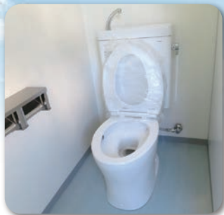
改修されたトイレです
