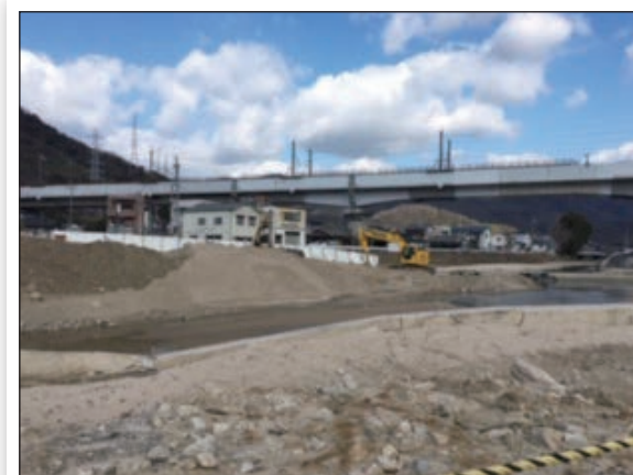
土砂の撤去早くしてー!
