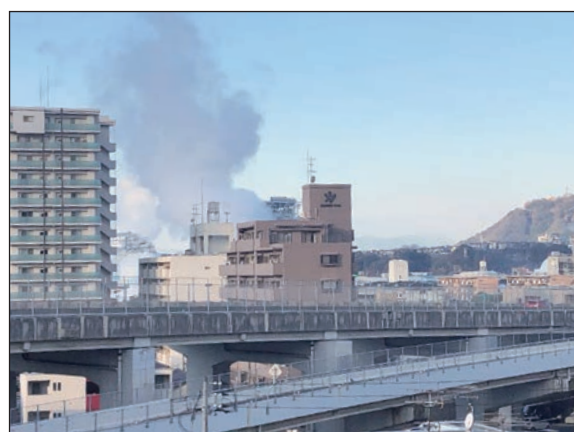
二酸化炭素の排出量は少ない？ (海田バイオマスパワー(株)海田発電所)
