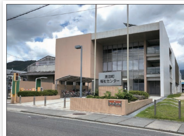
ここの地下駐車場が浸水しました
