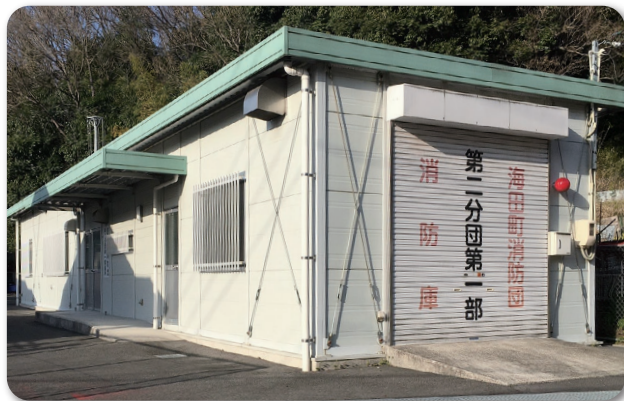
海田町で一番大きい国信の備蓄倉庫
