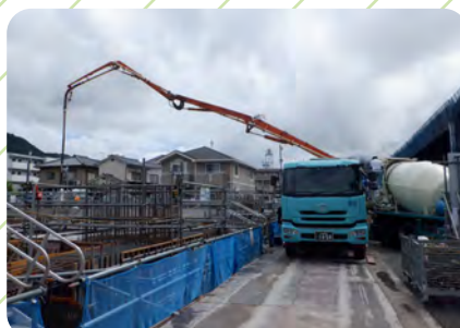
6 基礎コンクリート打設
