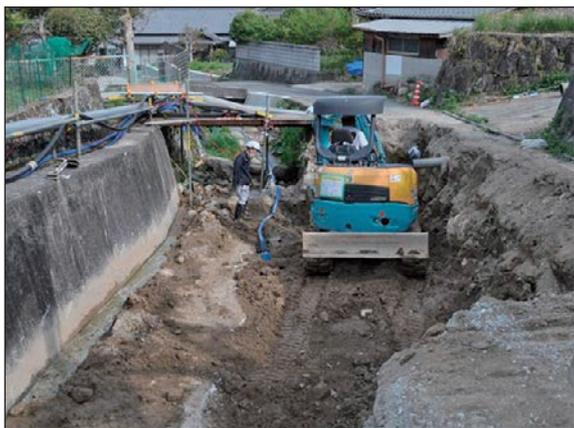
町道を掘り下げてから護岸擁壁を築く
