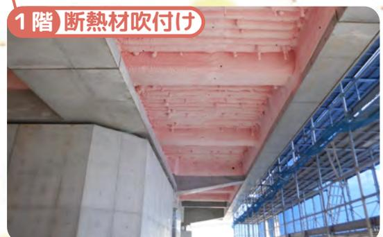
1階 断熱材吹付け
