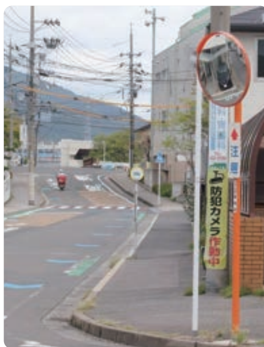
新しく設置したカーブミラー
