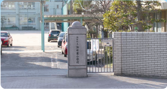
東小学校から建て替えます
