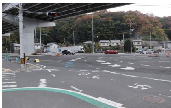
早く工事をして!!
