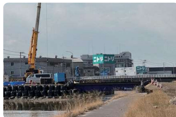
令和7年度も工事を続行します
