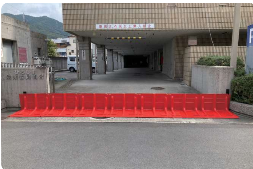
補助を受けて止水板が設置されました
