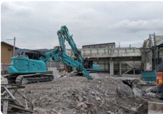
解体速度を遅らせた
