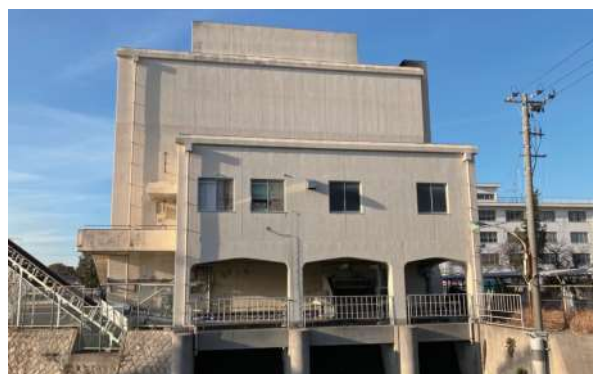
新排水機場の完成は14年先
