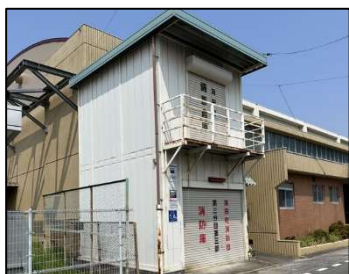
【消防庫・備蓄倉庫】
