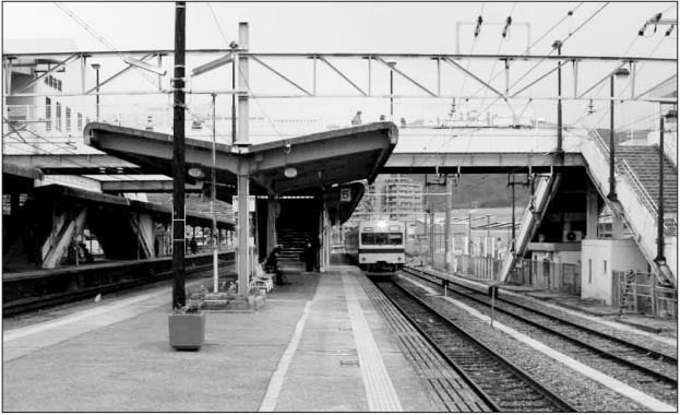
JR海田市駅バリアフリー推進事業 平成20年度から21年度にかけて駅構内にもエレベーターを設置し、プラットホームの段差を解消します。
