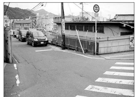
町道162号線歩道新設事業 歩道を整備し、歩行者の安全と快適な歩行空間を確保します
