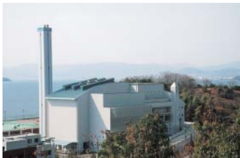
安芸クリーンセンター
