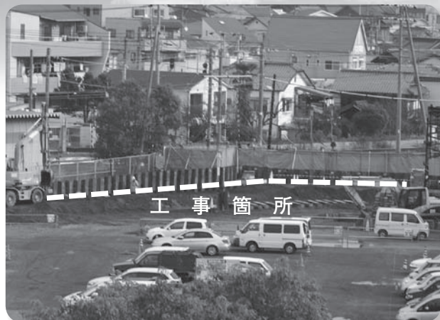
駅南口の水路工事中です
