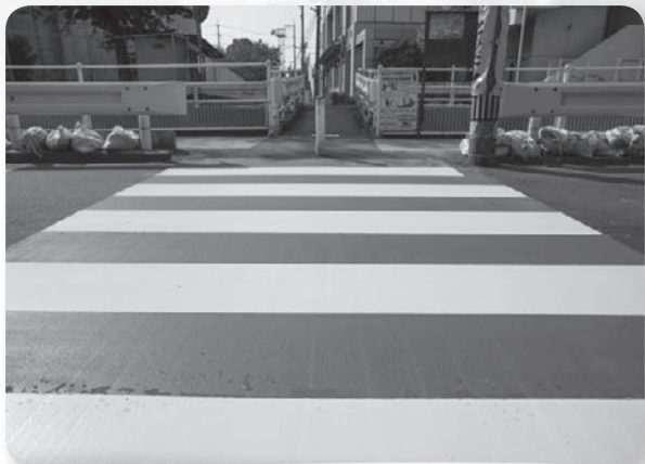
カラー舗装がしてあります
