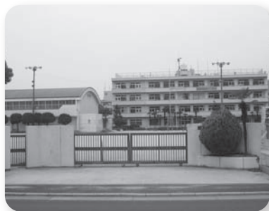
これから耐震工事が始まります
