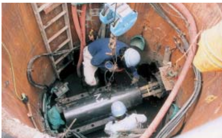
下水道の工事中です
