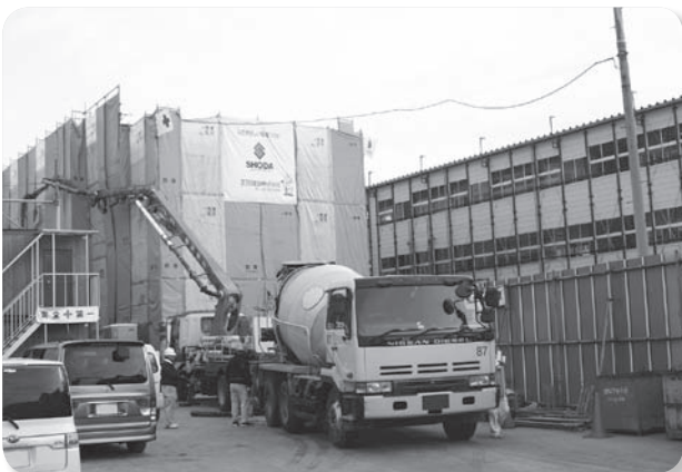
東小耐震化工事
