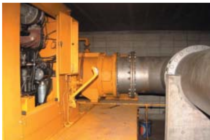
堀川ポンプ所
