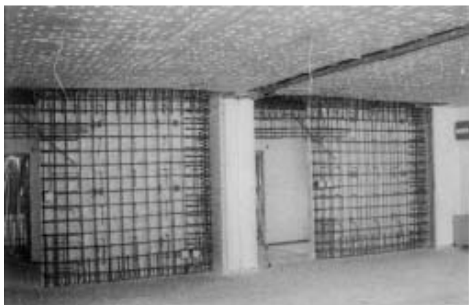
海田公民館は壁に鉄筋を入れ補強しました
