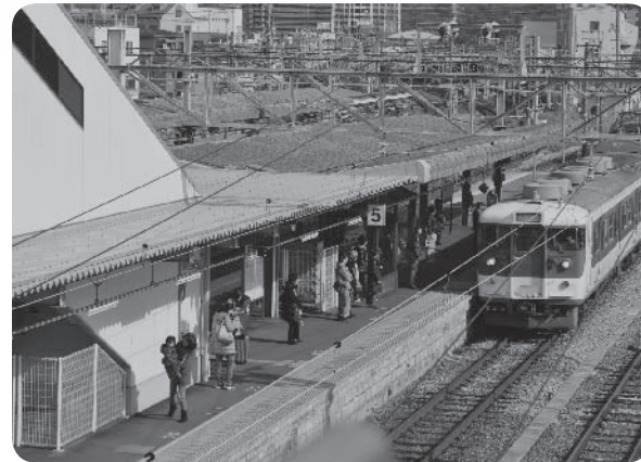
実現させるぞ！連続立体交差
