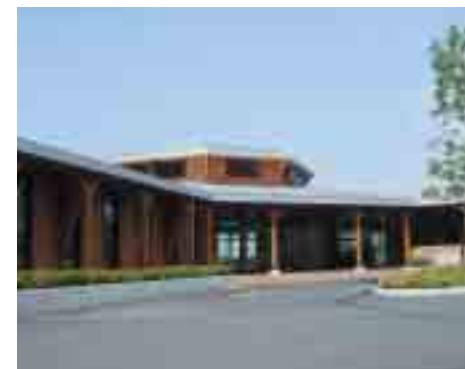
総合公園管理棟
