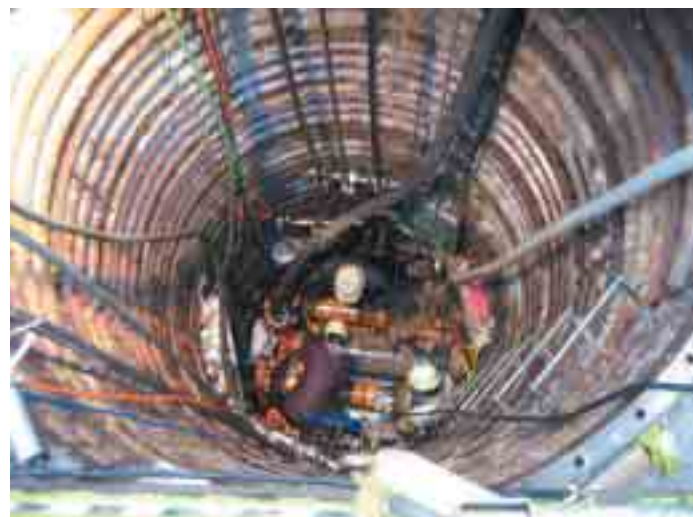
下水道の工事中（推進工法）
