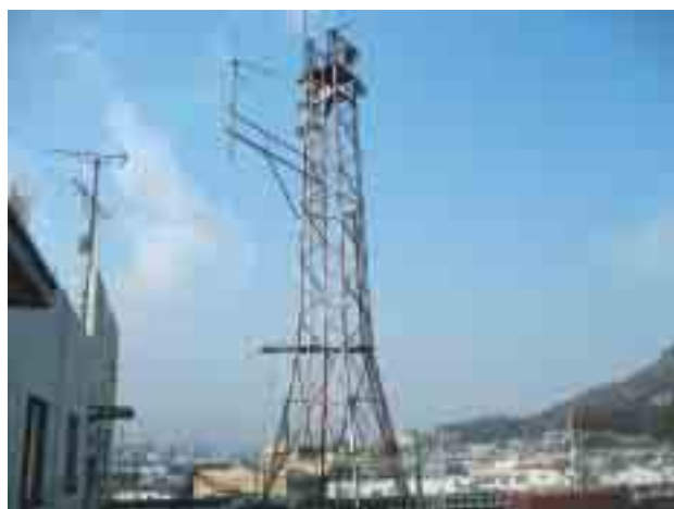
庁舎屋上の防災無線塔
