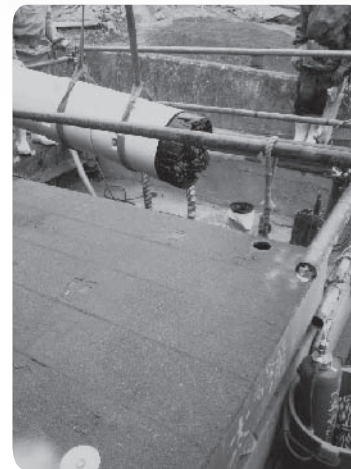
工事中の様子
