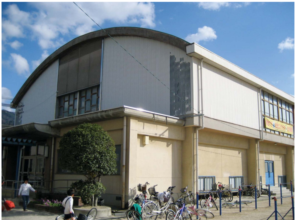
海田東小学校体育館
