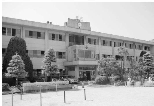
海田小学校の本館
