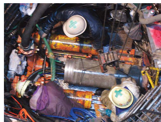
下水道の工事中です
