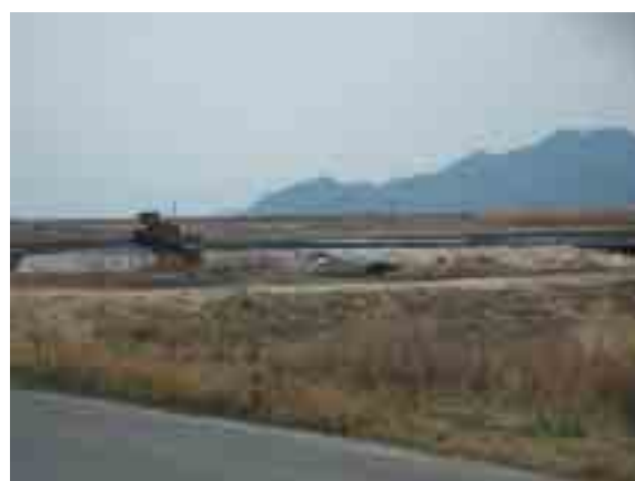
埋め立てごみ五日市処分場
