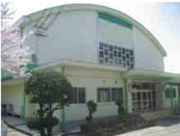
耐震化が済んだ東小体育館
