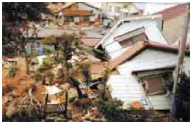
阪神大震災の家屋倒壊現場
