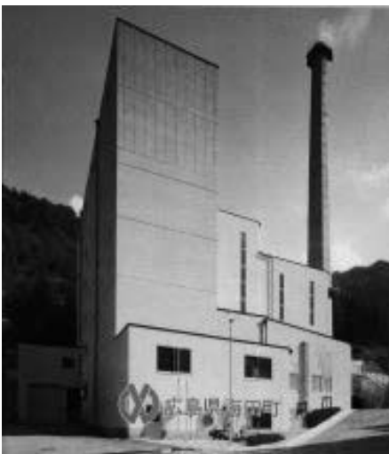
早期解体が求められる焼却炉
