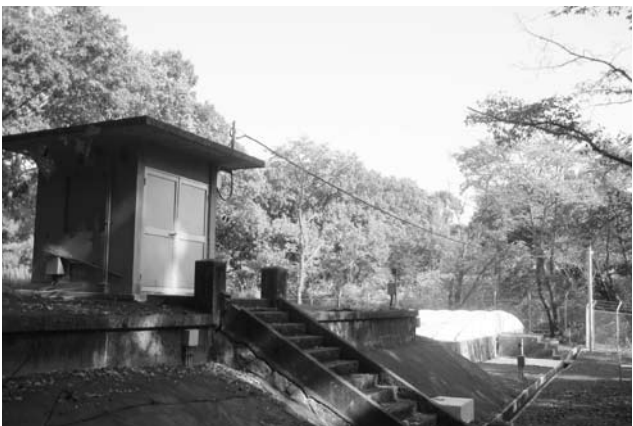
耐震診断中の石原配水池
