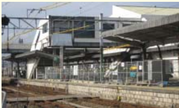
バリアフリー工事が進む海田市駅呉線ホーム
