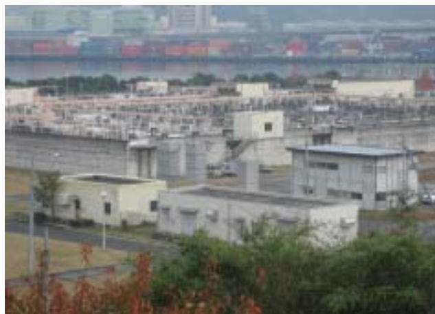
処理をお願いしている東部浄化センター
