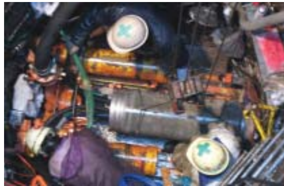
推進工法による下水道工事
