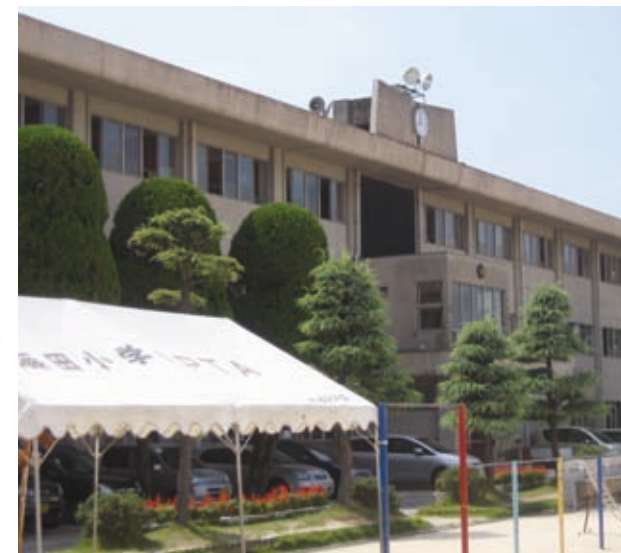
海田小学校の本館
