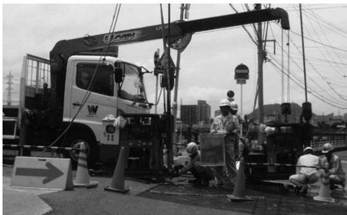
上市地区での工事
