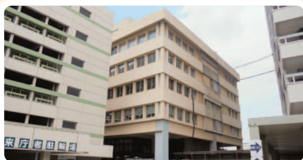
耐震工事中の福井市役所別館
