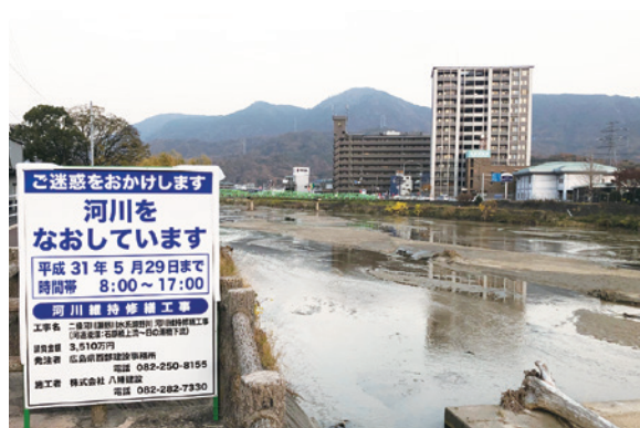
瀬野川の土砂は広島県が撤去します
