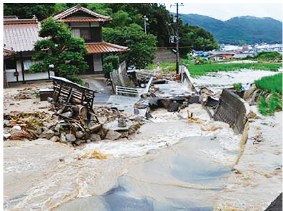
土石流に寸断された災害直後の町道6号
