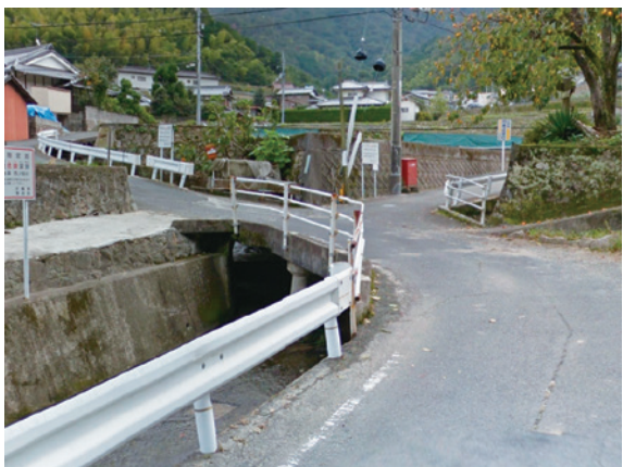
災害前の橋の様子
