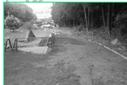
⑨【明飛川】★★★ 土砂の撤去、大型土のうの設置が完了しました。現在、えん堤整備に向けて、調査業務を実施中です。
