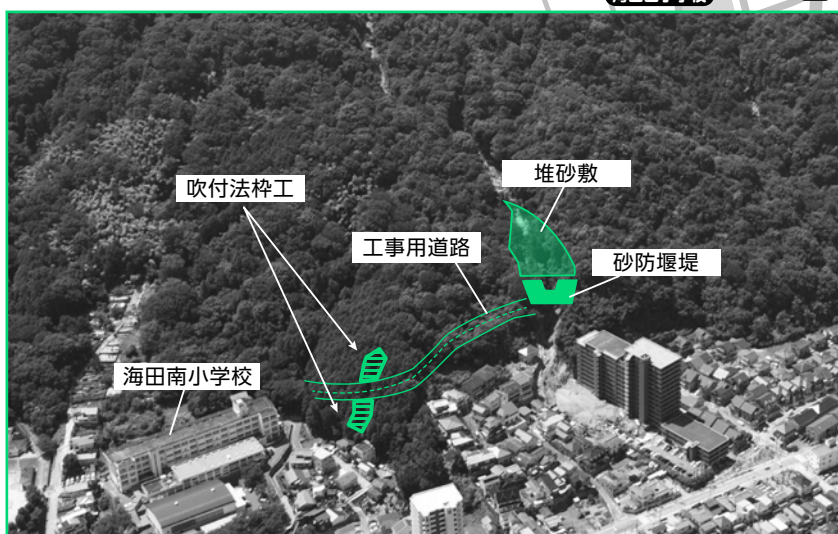
⑩【南幸川・南幸町】★★★ 3月に入札が不調になりましたが、5月にえん堤本体工事と急傾斜地崩壊対策工事の受注者が決定しました。今年度末に完了する予定です。
