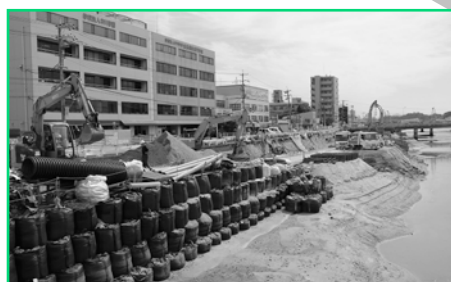
⑪【瀬野川左岸】★★★★ 3月に本復旧に向けた工事に着手し、今年度末に完了する予定です。
