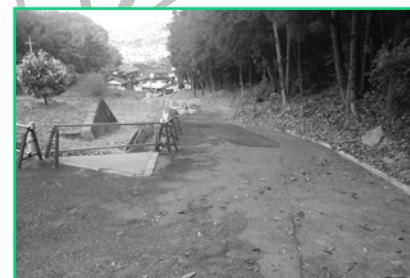
⑨【明飛川】★★★★ 明飛川沿いの町道304号線の復旧工事は、6月に工事着工し、9月末の完了予定です。また、現在、えん堤整備に向けて、調査業務を実施中です。
