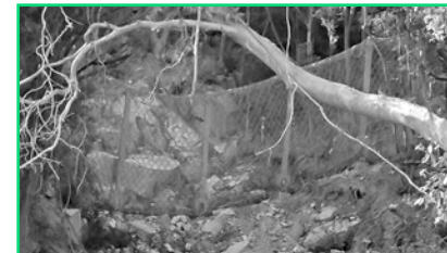
②【楠木谷川】★★★ えん堤本体工事については、7月に受注者が決定しました。
