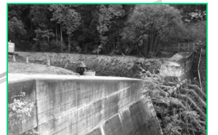
⑥【三迫川左支川】★★★★ えん堤に堆積した土砂の撤去については、今年度中に完了を予定しています。護岸工事については、6月に受注者が決定しました。今後、2カ年で工事を行う予定です。
