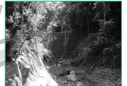
③【東唐谷川】★★★ 5月末に強靱ネットの設置が完了しました。現在、対策の内容を検討しています。
