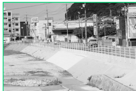
①【町道2号線】完了
