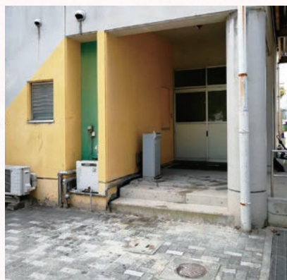
搬入口に改修します
