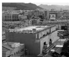
▲建設中の織田幹雄スクエア
