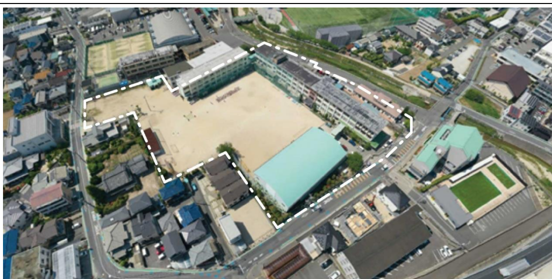
C 海田東小学校敷地 南側俯瞰
